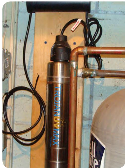
FIGURE 2: ULTRAVIOLET LIGHT SYSTEM
